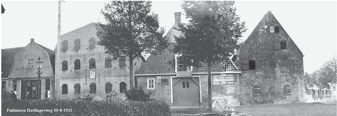
Pakhuizen aan de Harlingerweg te Franeker. De foto is gemaakt op 30 augustus 1931. (foto: collectie Gerard van der Velde)
