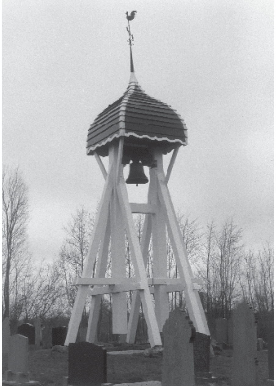
Klokkestoel met helmdak op het kerkhof van Legemeer. In 1604 werd bij de toen nog bestaande kerk een 'nij clockhuus' gebouwd. De vervallen kerk werd vermoedelijk in 1727 afgebroken (foto: Klazien Schroor)
