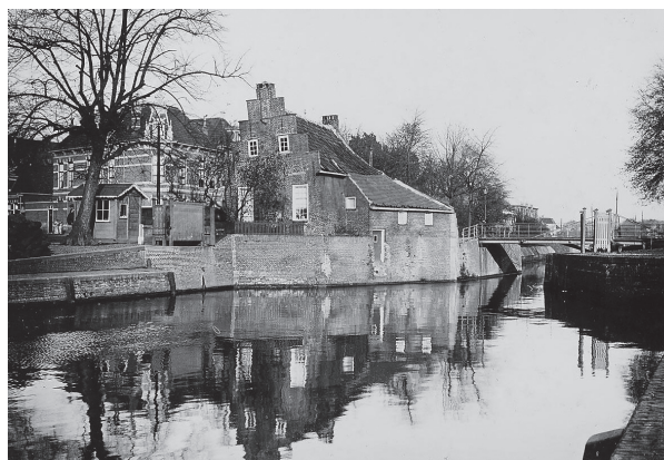
Het poortershuisje van de Steentilpoort in Groningen, met uitbouw in het water. Op de voorgrond het Damsterdiep
