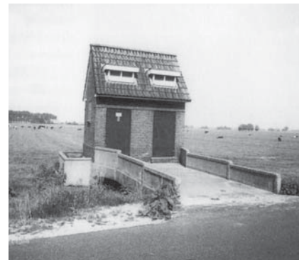
Trafohuisje te Munnekeburen
